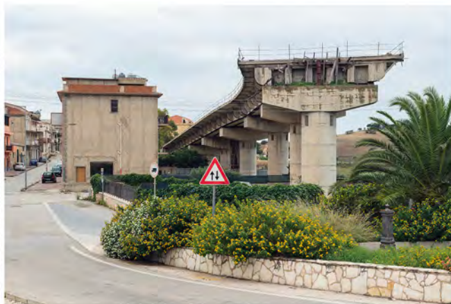
Een spookviaduct in Ribera op Sicilië. De maffia heeft een vinger in veel bouwprojecten
