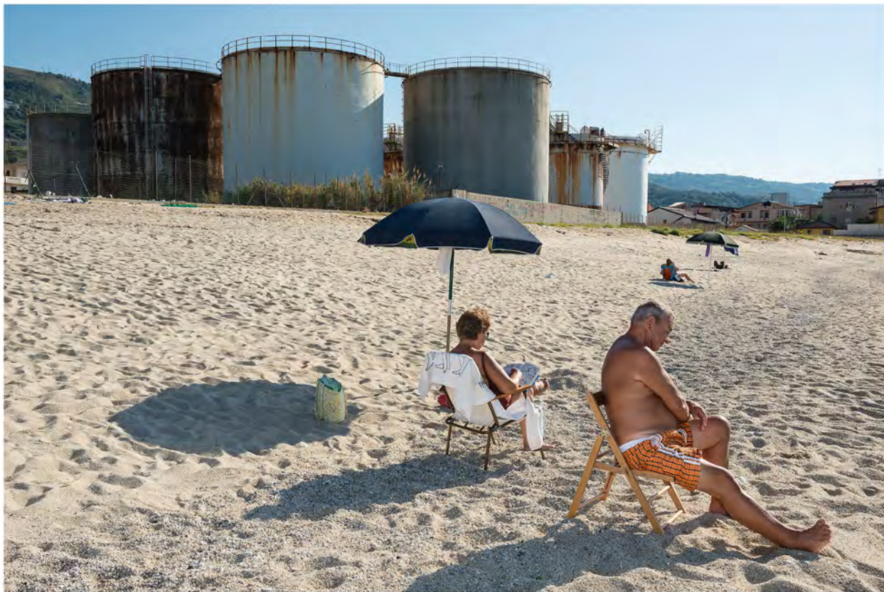
Verweerde olietanks op het strand van Pizzo in Calabrie.
